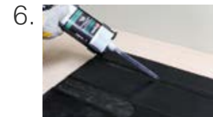
6. Permaflex Reparaturmaterial auftragen
