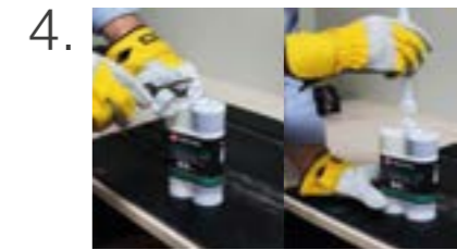
4. Verschluss entfernen und Mischkanüle befestigen
