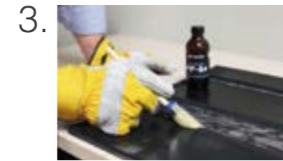
3. Vorbereitung mit speziellem PF-84 Primer
