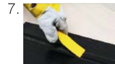
7. Falls notwendig verspachteln
